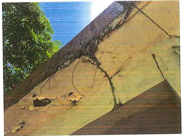
Des traces d'infiltrations sont présentes sous le chéneau.
