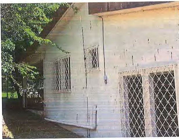
Des traces d'infiltrations sont présentes sous le chéneau.
